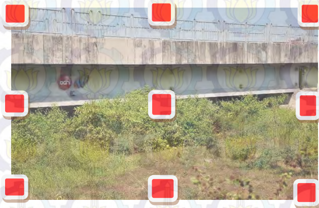
Gambar 4.5. Proyeksi Jembatan beserta Gambaran Posisi Kamera (kotak merah)
