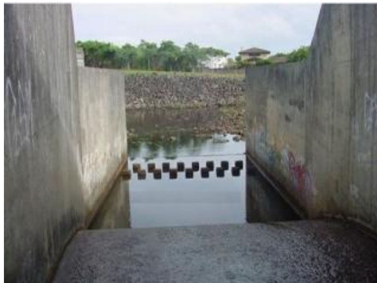
Gambar 1.1 Kolam olak dengan Balok-Balok Peredam ( https://www.ilmutekniksipil.com/bangunan-air/pengertian-bendungan )
