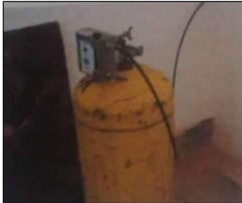
Gambar 4.20 Tabung Gas Klor dan *Gas Feeder* (PDAM, 2017)
