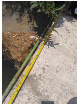
Gambar L. 5 Pengukuran Luas Penampang Basah Saluran
