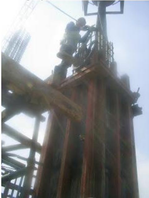
Gambar 4. 39 Proses Pengecoran Kolom Lapangan
