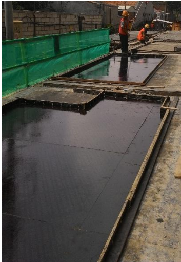
Gambar 4. 43 Cetakan Half-slab Lapangan
