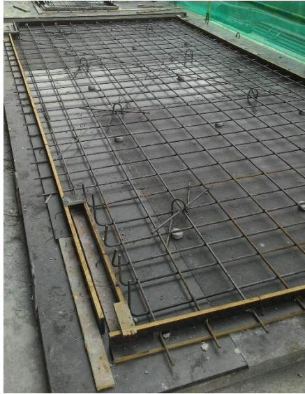
Gambar 4. 44 Cetakan Half-slab Lapangan
