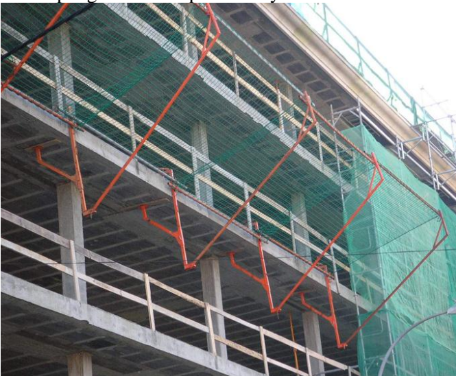
Gambar 4. 67 Contoh Pemasangan Safety Net
