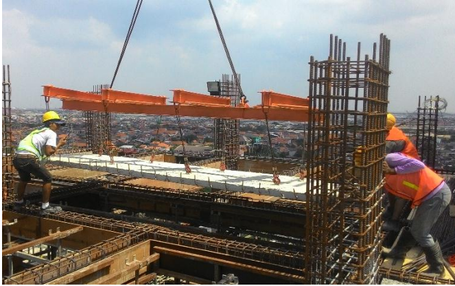
Gambar 4. 51 Pemasangan Half-slab Lapangan
