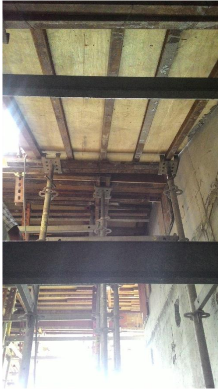
Gambar 4. 55 Pemasangan Schafolding dan Bekisting Tangga
