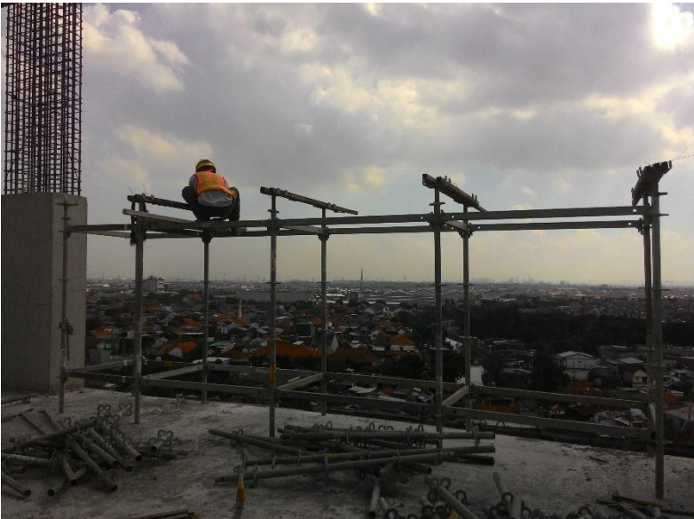
Gambar 4. 47 Proses Pemasangan Schafolding Lapangan
