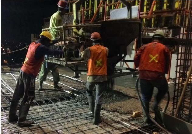
Gambar 4. 52 Proses Pengecoran Balok dan Plat Lantai Lapangan
