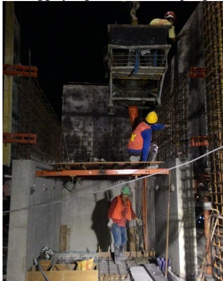
Gambar 4. 57 Proses Pengecoran Tangga
