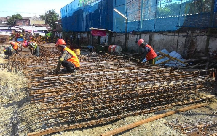
Gambar 4. 49 Fabrikasi Tulangan Balok Lapangan
