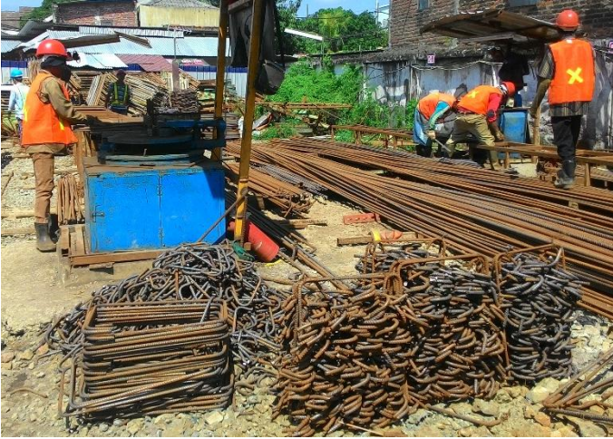
Gambar 4. 32 Proses Fabrikasi Lapangan
