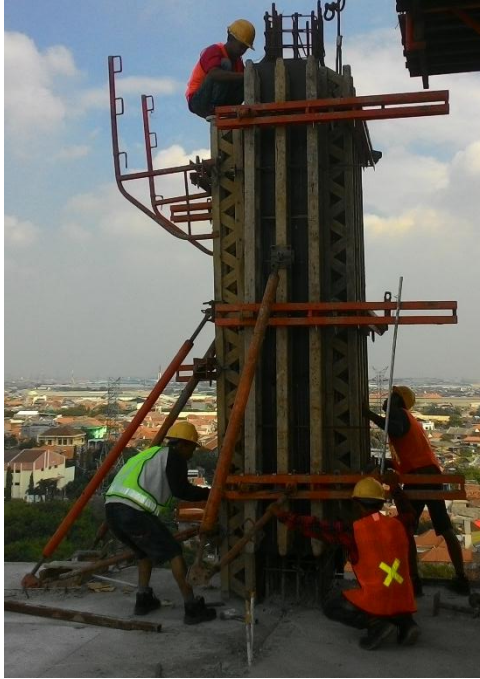
Gambar 4. 40 Proses Pembongkaran Bekisting Kolom Lapangan
