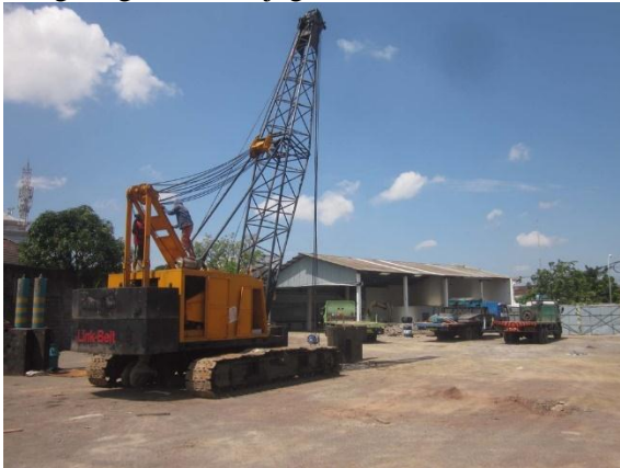
Gambar 4. 60 Lokasi Bedeng Pekerja dan Gudang Alat Berat
