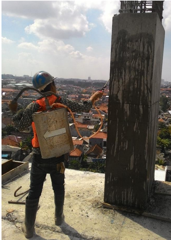
Gambar 4. 41 Proses Perawatan Kolom Lapangan
