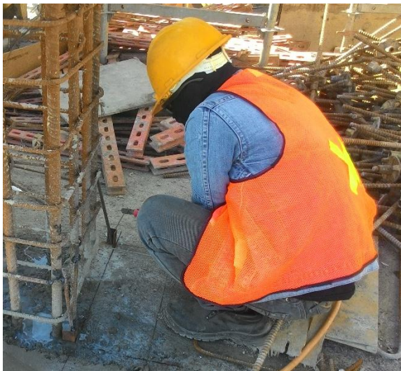
Gambar 4. 36 Pemasangan Sepatu Kolom Dilapangan
