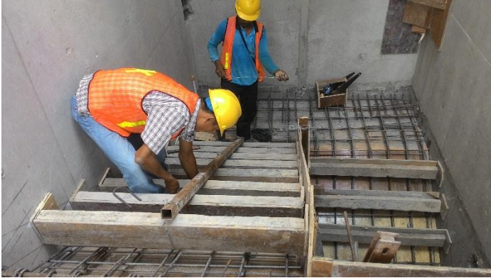
Gambar 4. 56 Pemasangan Tulangan Tangga
