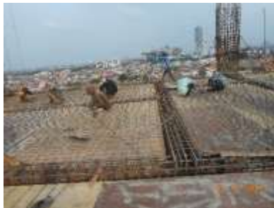
Gambar 4.7 Pemasangan besi
