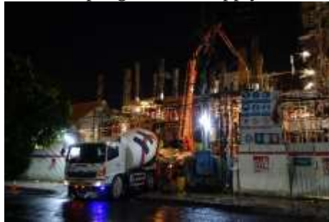
Gambar 4.10 Pengecoran menggunakan bucket
