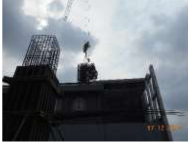
Gambar 4.6 Pengangkatan material menggunakan Tower Crane
