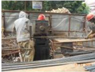
Gambar 4.3 Pemotongan besi menggunakan BarCutter Dalam kegiatan pemotongan besi dibutuhkan 3 resources , yaitu:
