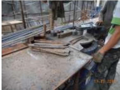
Gambar 4.4 Pembengkokan besi menggunakan Bar Bender Dalam kegiatan pembengkokan besi dibutuhkan 3 resources , yaitu:
