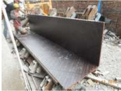
Gambar 4.8 Perakitan bekisting
