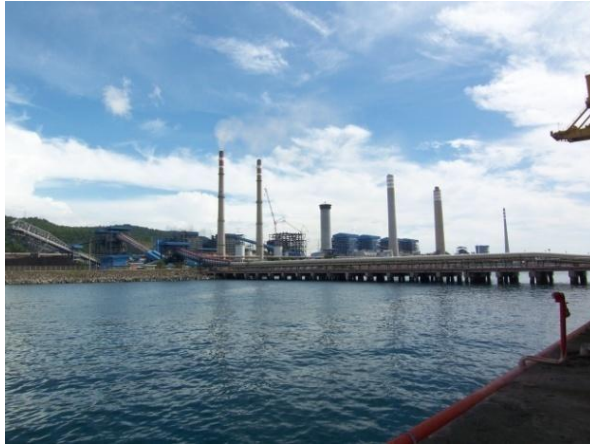
Gambar 4 - 2. Salah Satu Sudut Komplek PLTU Paiton.
