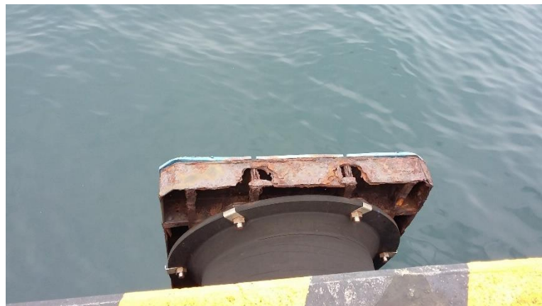
Gambar 4 - 14. Kondisi Fender Dermaga.
