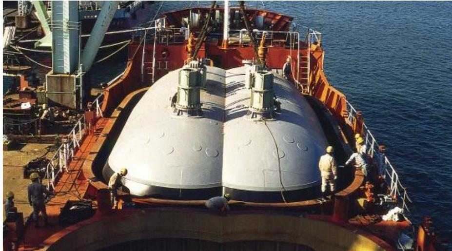
Gambar 5.19. Pemasangan Tangki *Bilobe* pada Kapal
