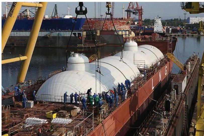
Gambar 5.18. Pemasangan Tangki Silinder pada Kapal
