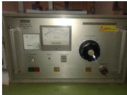
Gambar 3.2. Control box yang digunakan dalam pengujian
