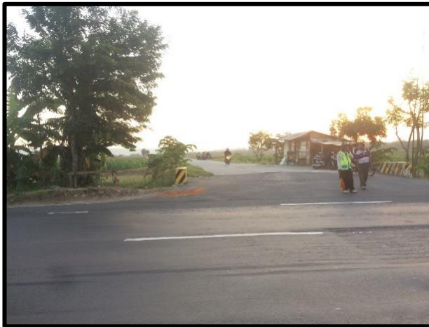
Gambar 4.10 : Jalan Eksisting di Desa Genaharjo
