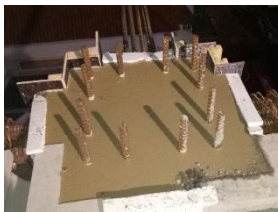
Gambar 25.4.15 : Kepala Kolom yang Telah Digrouting (Sumber: Dokumentasi Lapangan)
