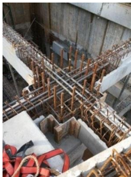
Gambar 26.4.16 : Pemesian Kepala Kolom (Sumber: Dokumentasi Lapangan)
