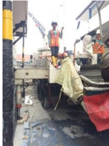
Gambar 33.4.23 : Pengecoran Menggunakan Concrete Pump (Sumber: Dokumentasi Lapangan)
