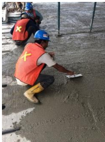
Gambar 34.4.24 : Perataan Beton (Sumber: Dokumentasi Lapangan)
