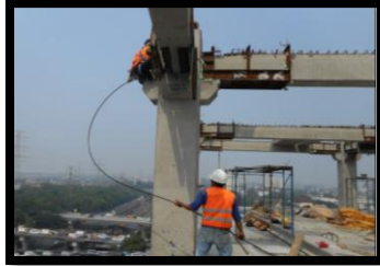
Gambar 30.4.20 : Penginstallan Strand (Sumber: Dokumentasi Lapangan)
