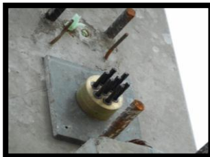
Gambar 32.4.22 : Pemotongan Sisa Strand (Sumber: Dokumentasi Lapangan)
