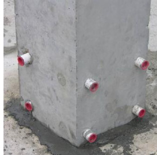
Gambar 20.4.10 : Pekerjaan Grouting Splice Sleeve (Sumber: Dokumentasi Lapangan)
