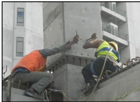
Gambar 12.4.2 : Instalasi Kolom Pracetak (Sumber: Dokumentasi di lapangan)
