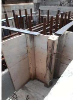
Gambar 29.4.19 : Kepala Kolom Yang Telah Dipasang Bekisting
