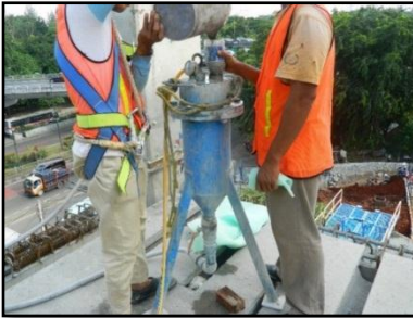
Gambar 20.4.10 : Pekerjaan Grouting Splice Sleeve (Sumber: Dokumentasi Lapangan)
