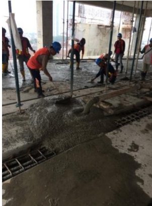
Gambar 16.4.6 : Pengecoran Second Concrete (Sumber: Dokumentasi di lapangan)
