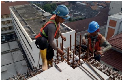
Gambar 13.4.3 : Pemasangan Tulangan Kepala Kolom (Sumber: Dokumentasi di lapangan)
