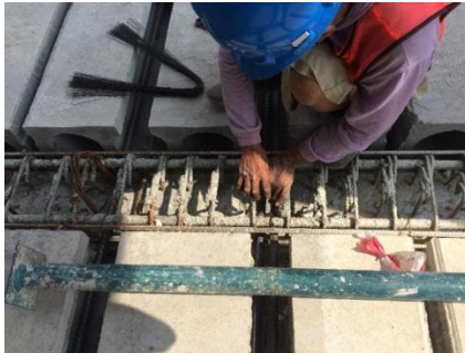
Gambar 27.4.17 : Pembesian Tulangan Tambahan pada Balok dan HCS (Sumber: Dokumentasi Lapangan)
