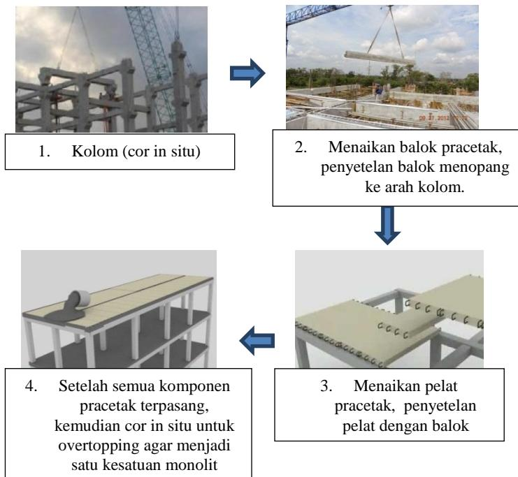
**Gambar 3. 10. Proses Pemasangan**
