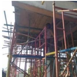
Gambar 4. 98 Pembongkaran Bekisting
