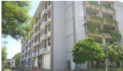
Gambar 4.6 Bangunan Rusun Siwalankerto
