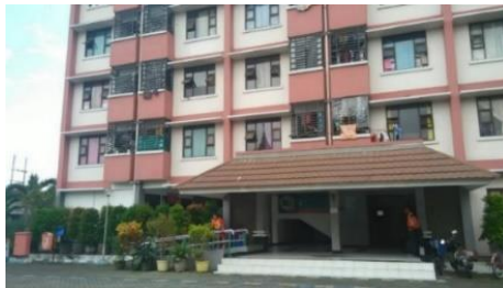
Gambar 4.3 Bangunan Rusun Jambangan (Sumber: Hasil Survey, 2018)
