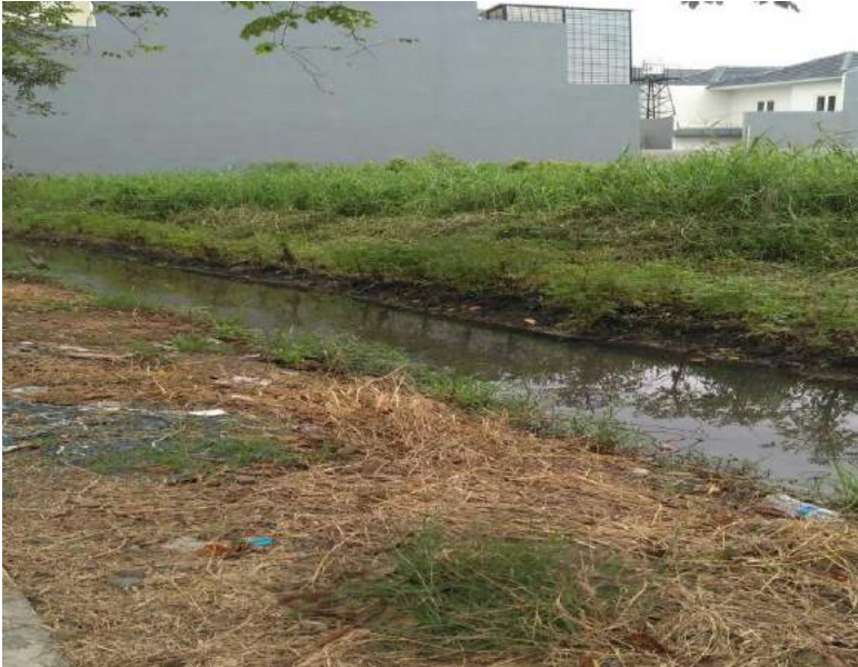
Gambar 0-2 Saluran Eksisting Perumahan Bumi Marina Emas Selatan
