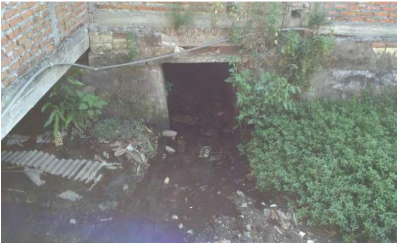
Gambar 0-3 Saluran Outlet Perumahan Bumi Marina Emas Selatan
