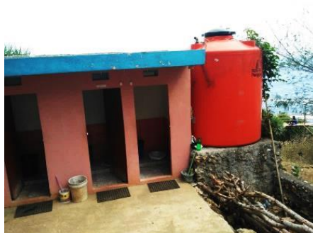
Gambar 4. 12. Jaringan Air Bersih dengan membeli tangki di Kawasan Wisata Pantai Timang Sumber: Survei Primer, 2017
