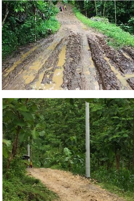
Gambar 4. 15. Kondisi Jalan batu-batuan dan kondisi jalan disaat hujan di Kawasan Wisata Pantai Timang
