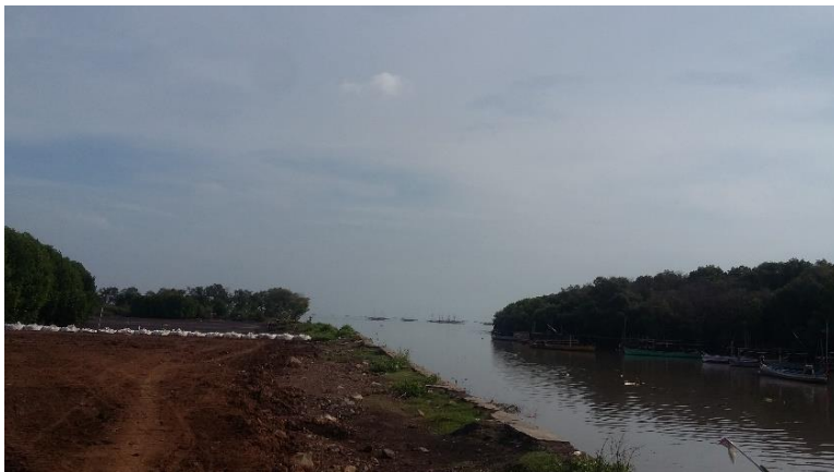
Gambar 1. 3 Lokasi proyek pengembangan pelabuhan perikanan Kota Pasuruan (Sumber: Dokumentasi survey)
