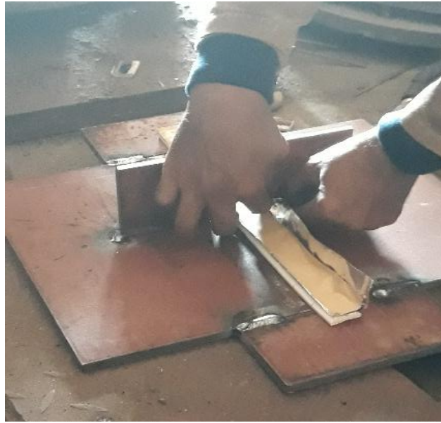
Gambar 3.5 Pemasangan Stopper dan Backing Material
