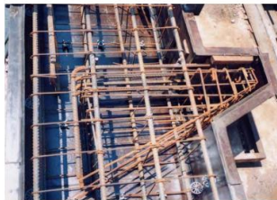
Gambar 2. 14 Contoh Penulangan Corbel Sumber :FIB (Fig.9-18)
