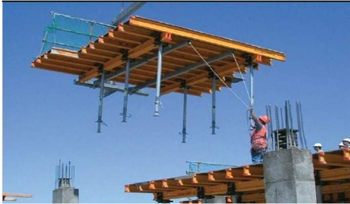
Gambar 2. 3 Bekisting Sistem (Sumber : Kitairu)
