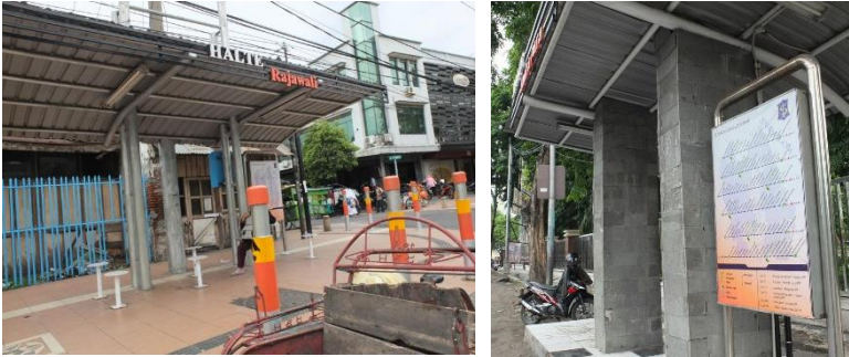
Gambar 4.15. Fasilitas Halte Transportasi di Jl. Rajawali
