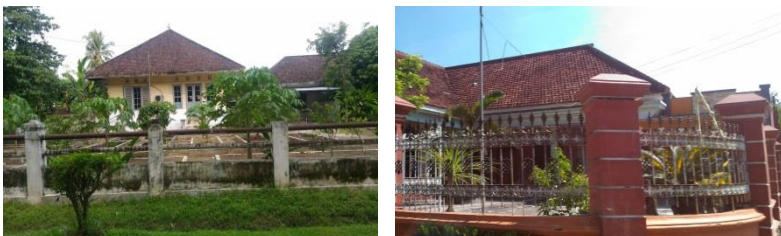
Gambar IV. 41 Kondisi Sarana Penginapan di Desa Semboro
