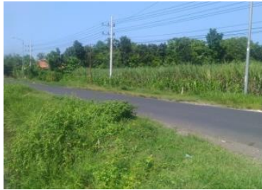
Gambar IV. 43 Kondisi Perkerasan Jalan di Desa Semboro Sumber : Survey Primer, 2018
