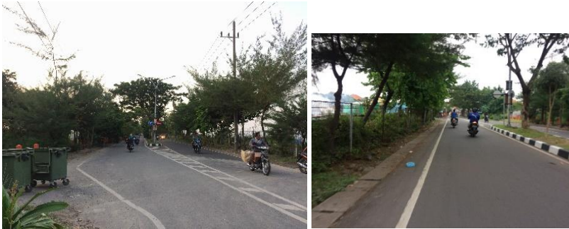
Gambar IV.10 Kondisi Jalan yang Menghubungkan DTW Sumber: Survey Primer, 2018
