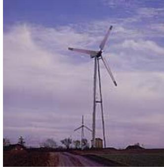
Gambar 2. 15 Turbin angin dengan tipe *hybrid tower* [7]
