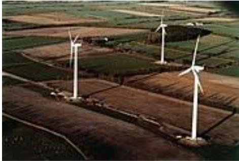
Gambar 2. 11 Turbin angin dengan tipe *tubular steel tower* [7]
