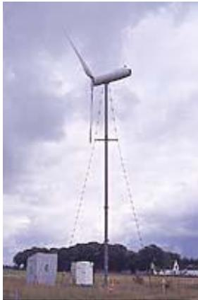
Gambar 2.14 Turbin angin dengan tipe *guyed pole tower* [7]
