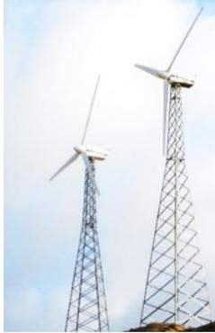
Gambar 2.12 Turbin angin dengan tipe *lattice tower* [7]
