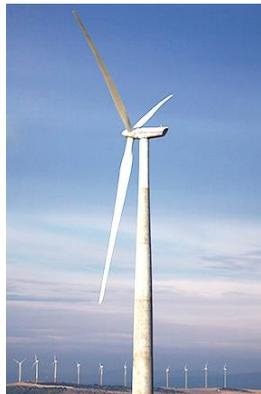
Gambar 2.13 Turbin angin dengan tipe *concrete tower* [8]
