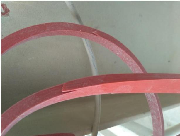
**Gambar 4.6** Seal yang Digunakan pada Sulphur Filter FIL-1001A/B dengan Material *Red Silicone Rubber*
