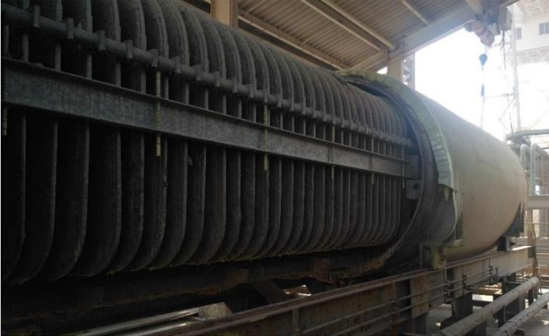
**Gambar 4.1** *Preventive Maintenance* pada Sulphur Filter FIL-1001A/B
