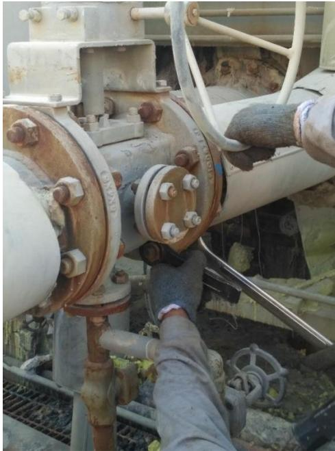
**Gambar 4.2** Proses Perbaikan *Flange* Sambungan Pipa
