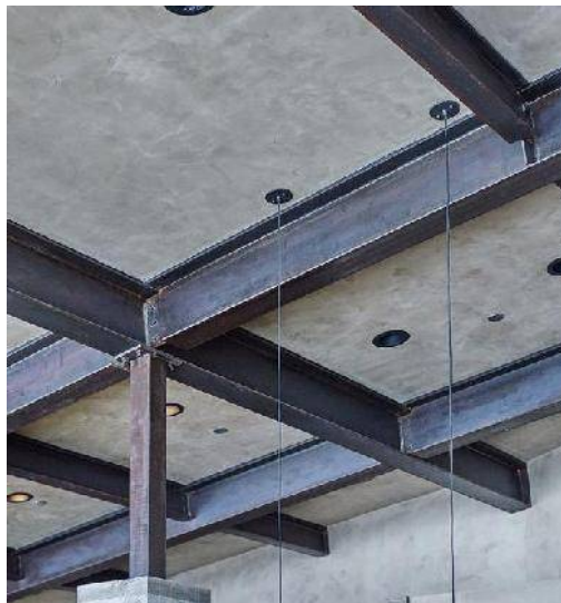
Gambar 4.19. Struktur Baja Expose Dalam (Sumber : http://centresky.com )
