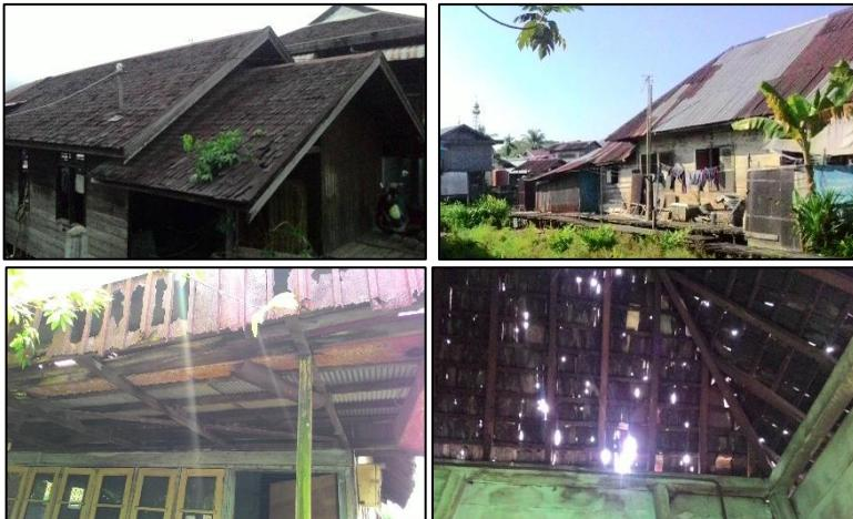
**Gambar 4. 29** Kondisi fisik material atap bangunan rumah tepi sungai
