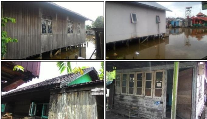
**Gambar 4. 31** Kondisi fisik material dinding pada bangunan rumah tepi sungai
