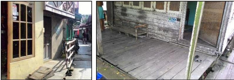
**Gambar 4. 33** Kondisi fisik material lantai pada bangunan rumah
