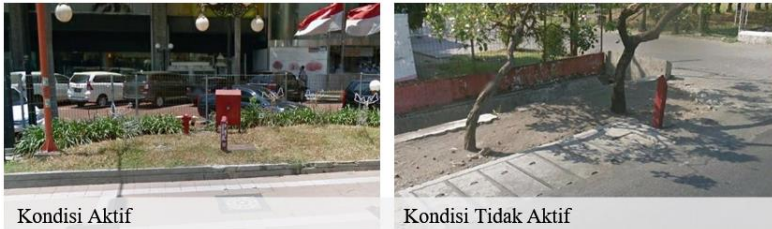
Gambar 4.15 Kondisi Sumur Kebakaran Kota Surabaya Sumber : Masterplan Dinas Kebakaran Kota Surabaya 2016-2021
