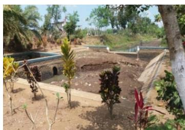
Gambar 2.3 Sedimentasi pada Saluran Primer
