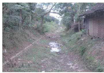
Gambar 2.4 Sedimentasi Pada Saluran Sek. Besini
