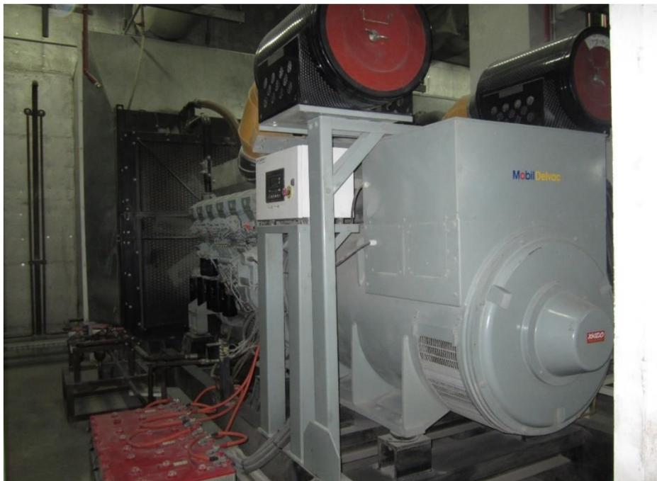
Diesel Engine 2000KVA
