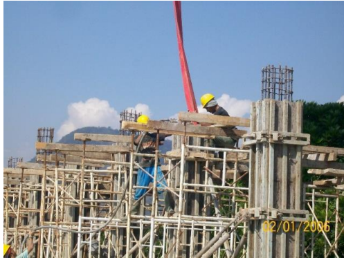
Gambar 4IV.50 : Contoh pematatan beton kolom dengan vibrator
