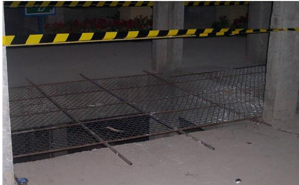
Gambar5.18 : Contoh pemasangan kawat ram galvanis pada lubang struktur
