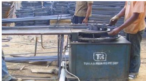
Gambar 4.61 : Contoh pembengkokan besi tulangan
