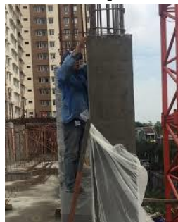
Gambar 4.54 : Contoh proses perawatan beton kolom
