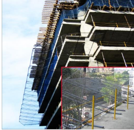
Gambar 5.14 : Contoh pemasangan safety net vertical
