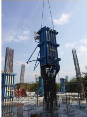
Gambar 4.43 : Contoh pengangkatan bekisting kolom dengan tower crane
