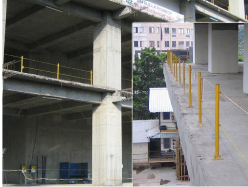
Gambar 5.16 : Contoh penggunaan safety railing pada tepi bangunan
