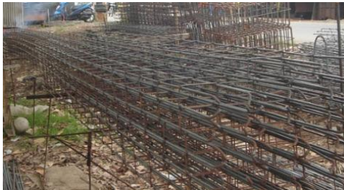
Gambar 4.62 : Contoh tulangan balok yang telah dirakit
