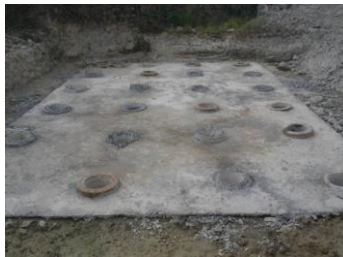
Gambar 4.16 : Contoh pembuatan lantai kerja
