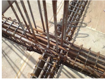
Gambar 4.66 : Contoh pemasangan tulangan balok
