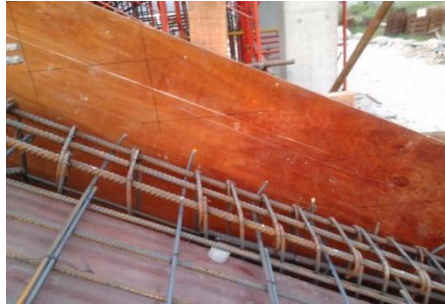
Gambar 4.73 : Contoh marking anak tangga
