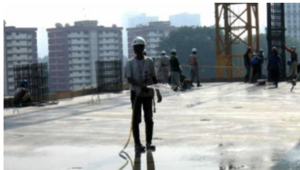
Gambar 4.72 : Contoh perawatan balok plat
