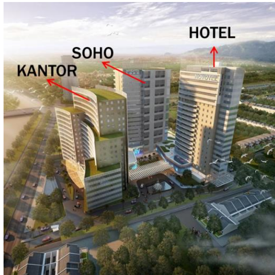
Gambar 4.1 : Proyek The Samator
