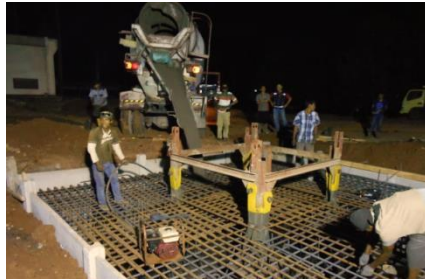
Gambar 4.20 : Contoh pekerjaan pengecoran base tower crane 11. Pemasangan mast section menggunakan mobile crane
