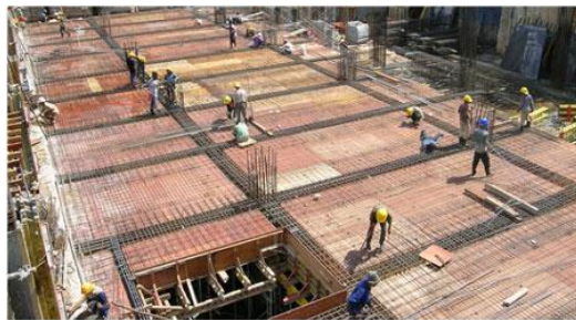
Gambar 4.64 : Contoh pemasangan tulangan plat
