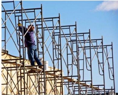
Gambar 4.56 : Contoh penyusunan scaffolding
