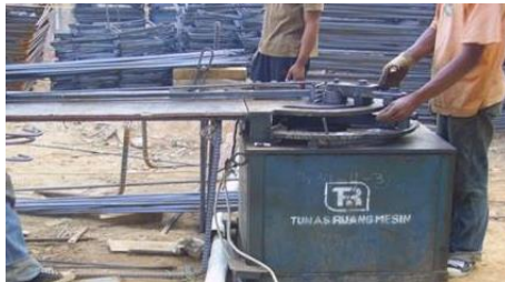
Gambar 4.33 : Contoh pembengkokan besi tulangan
