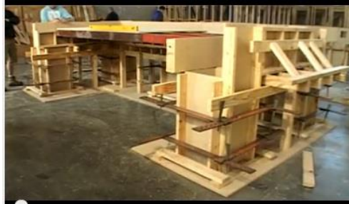
Gambar 4.55 : Contoh fabrikasi balok dan plat
