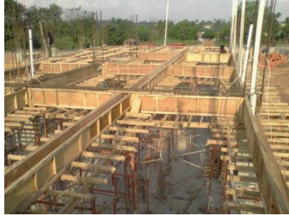
Gambar 4.58 : Contoh pemasangan bekisting balok
