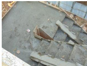
Gambar 4.81 : Contoh pembongkaran plat tangga
