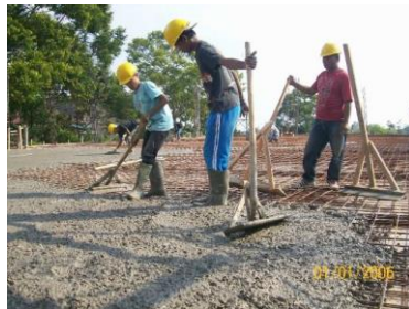
Gambar 4.70 : Contoh perataan beton dengan ruskam kayu
