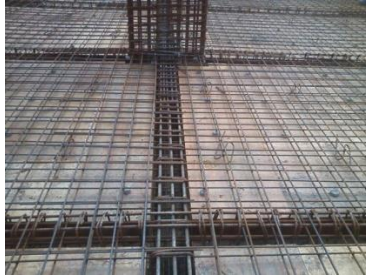
Gambar 4.65 : Contoh pemasangan tulangan balok dan plat
