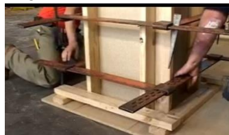
Gambar 4.39 : Contoh proses fabrikasi bekisting kolom
