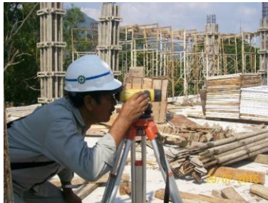
Gambar 4.71 : Contoh pengecekan ketebalan dan elevasi plat
