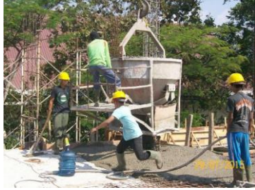
Gambar 4.68 : Contoh penuangan adonan beton pada area cor
