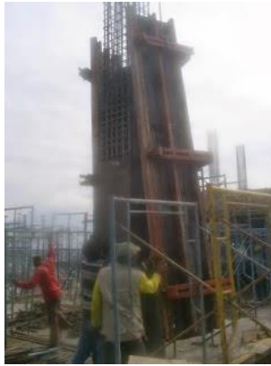
Gambar 4.51 : Contoh pengerjaan pembongkaran bekisting kolom
