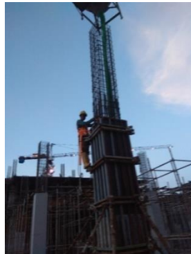
Gambar 4.49 : Contoh pengecoran kolom
