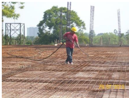
Gambar 4.67 : Contoh pembersihan area pegecoran balok dan plat
