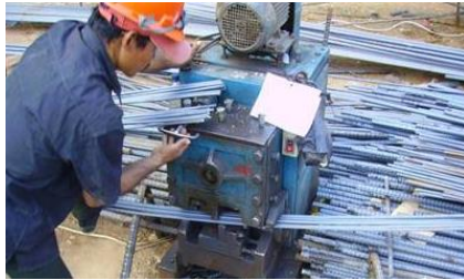
Gambar 4.75 : Contoh pemotongan besi tulangan
