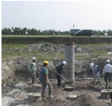
Gambar 4.15 : Contoh proses pemotongan kepala tiang pancang
