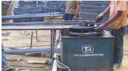
Gambar 4.76 : Contoh pembengkokan besi tulangan
