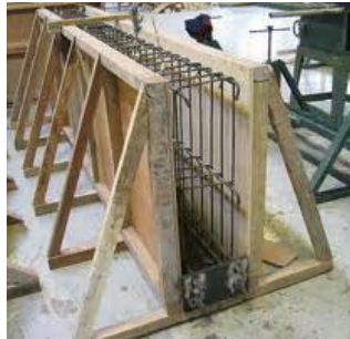
Gambar 4.63 : Contoh pemasangan tulang balok
