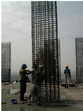
Gambar 4.36 : Contoh pemasangan tulangan kolom
