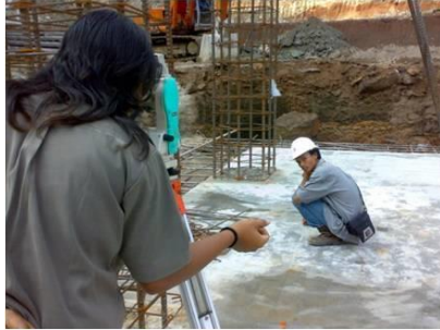
Gambar 4.29 : Contoh pekerjaan marking kolom
