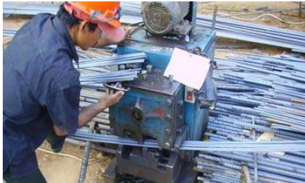
Gambar 4.32 : Contoh pemotongan besi tulangan
