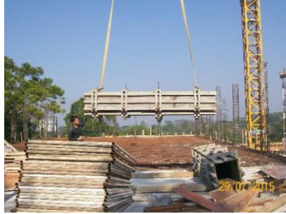
Gambar 4.41 : Contoh pengangkutan bekisting kolom dengan tower crane
