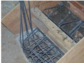
Gambar 4.79 : Contoh beton ditunangkan ke area pondasi tangga
