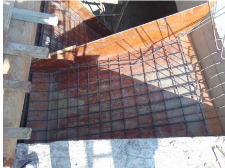
Gambar 4.74 : Contoh kemiringan plywood pada bekisting
