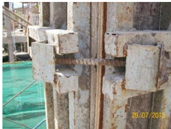
Gambar 4.45 : Contoh pemasangan clomp
