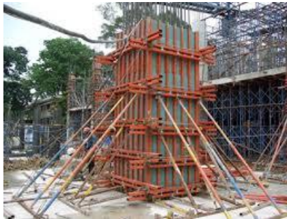
Gambar 4.44 : Contoh pemasangan bekisting kolom
