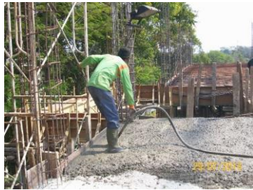
Gambar 4.69 : Contoh adonan beton yang dipadatkan dengan vibrator
