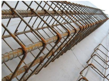
Gambar 4.34 : Contoh besi tulangan kolom yang telah dirakit
