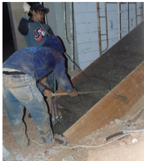
Gambar 4.80 : Contoh beton disebarkan dari atas tangga ke bawah
