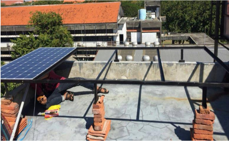
Gambar 4. 4 Pemasangan Modul Panel 200 WP pada Rooftop
