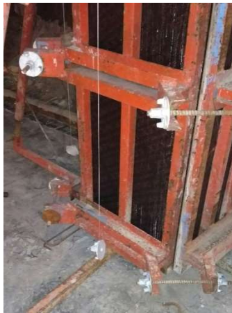
Gambar 5. 2: Alat Bantu Unting-unting untuk Mempermudah Pengecekan Bekisting
