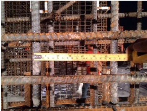
Gambar 5. 1: Contoh pengukuran jarak tulangan pada tulangan kolom
