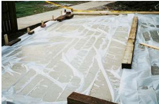
Gambar 5. 6: Salah Satu Proses Curing Beton
