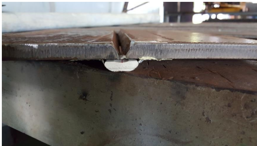
Proses Pemasangan Backing Ceramic Sebelum Proses Pengelasan
