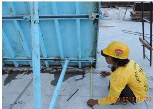
Gambar 8. 11 Proses Cek Vertikalisasi
