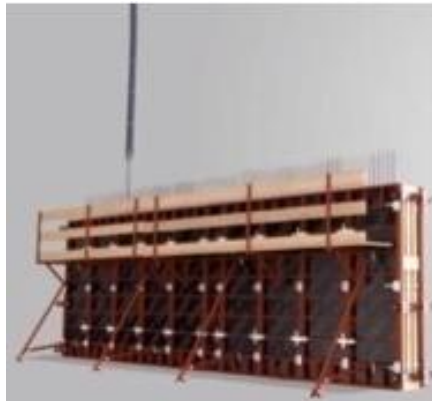
Gambar 8. 16 Pengecoran Shearwall dengan Pipa Tremi
