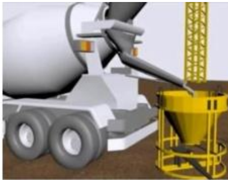
Gambar 8. 14 Penuangan Beton Ready Mix
