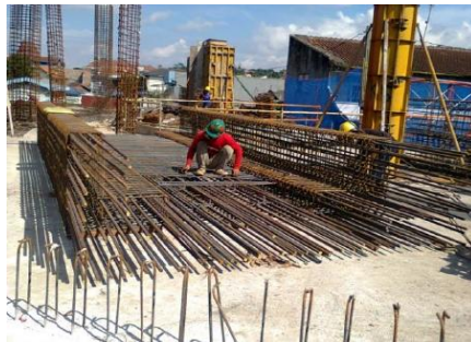
Gambar 8. 3 Perakitan Tulangan Shearwall
