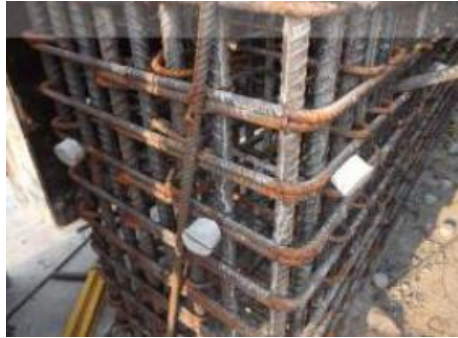
Gambar 8. 9 Pemasangan Beton Decking
