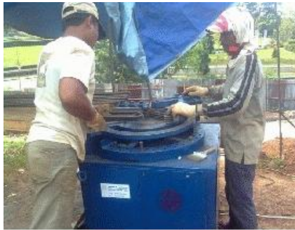
Gambar 8. 2 Proses Fabrikasi Tulangan
