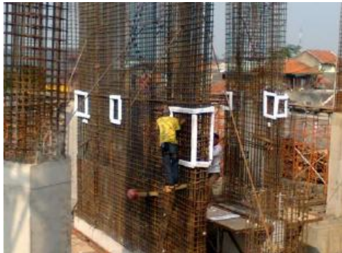
Gambar 8. 8 Pemasangan Styrofoam Pada Daerah Blockout
