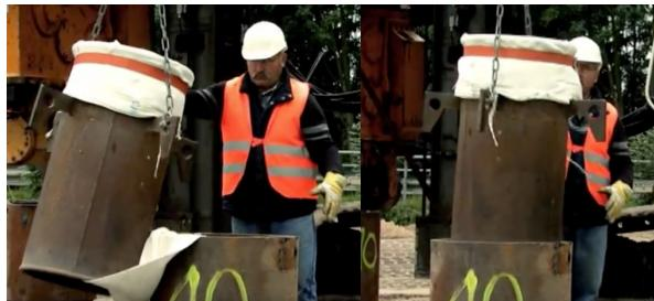
**Gambar 8.10** Pemasangan *Geotextile*
