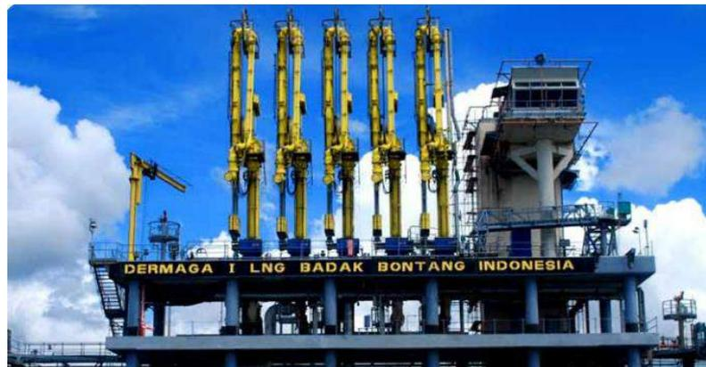
Gambar 4-10 Alat Bongkar Muat LNG
