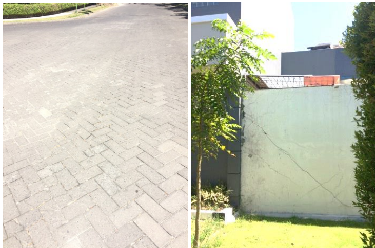
Gambar 4. 12 Kondisi lapangan di Titik Perumahan Pantai Mentari Kenjeran
