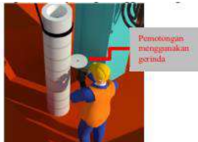
Gambar 10. 11 Pemotongan Tiang Pancang
