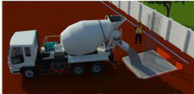
Gambar 10. 16 pengecoran pilecap
