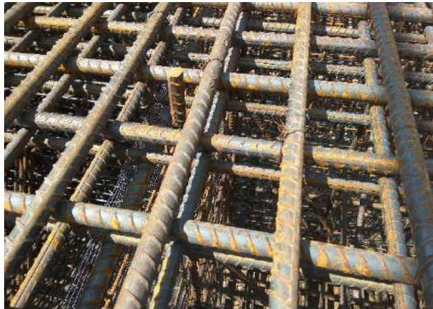
Gambar 3. 13 Penulangan Pondasi
