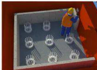
Gambar 10. 14 pemasangan bekisting pilecap
