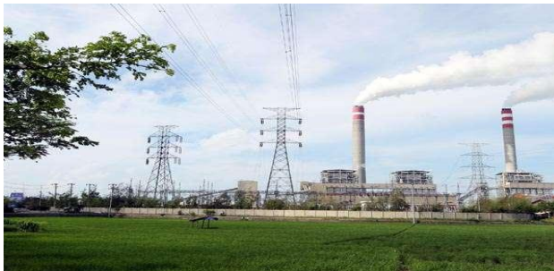
Gambar 1.1 Lokasi dan Penampakan PLTU Tanjung Jati B
