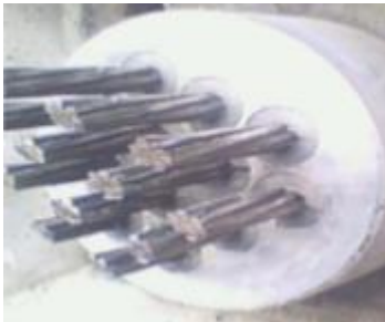
Gambar 9. 8 Pematangan Tendon Gambar 9. 9 Pemasangan Anchor Block dan Wedges
