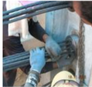
Gambar 9. 8 Pematangan Tendon Gambar 9. 9 Pemasangan Anchor Block dan Wedges
