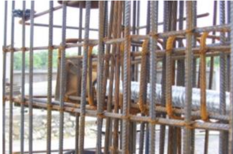
Gambar 9. 7 Pemasangan Angkur Hidup Sc
