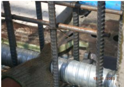
Gambar 9. 6 Penyambungan Duct
