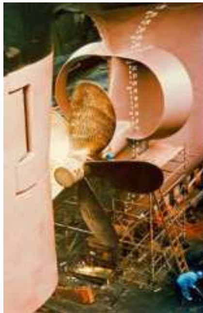
Gambar 2. 15 Schneekluth Duct Instalations ( Sumber : www.schneekluth.com )
