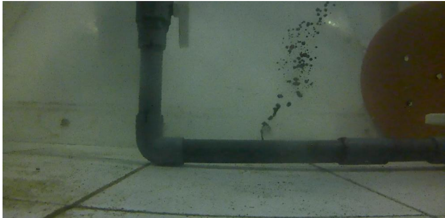
Gambar 5.2 Minyak yang keluar pada kebocoran ukuran 2 mm
