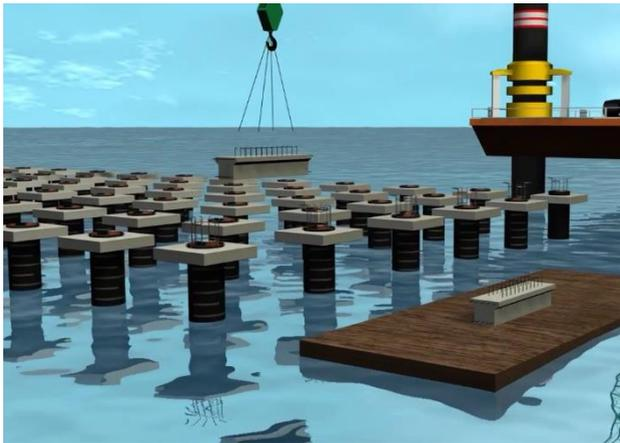
Gambar 7. 7 Pemasangan balok precast
