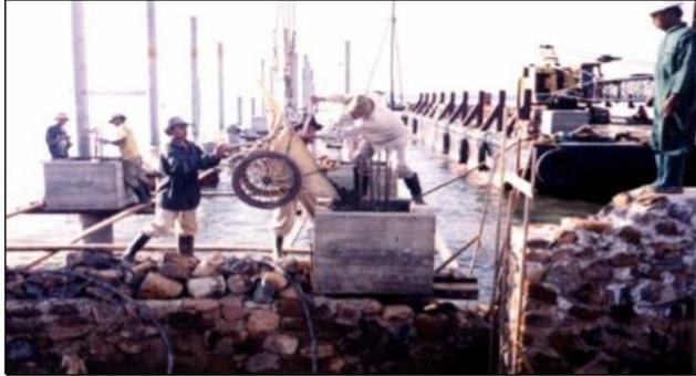
Gambar 7. 6 Pengecoran pilecap
