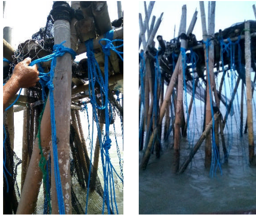
Gambar 3.25 Pengikatan Beton pada Bagan
