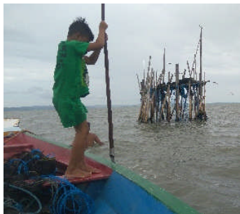
Gambar 3.24 Proses Pengangkutan Beton dengan Perahu Menuju Bagan
