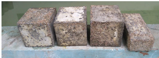
Gambar 3.28 Beton Sebelum Dibersihkan
