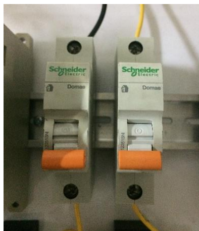
Figure 4. 16 Mini Circuit Breaker
