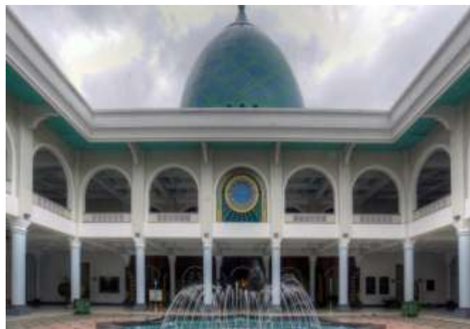
Gambar 2.18 Pelataran Terbuka Pada Masjid al-Akbar
