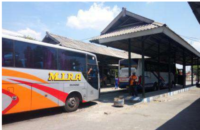
Gambar 2.11 Terminal Bus Purboyo Madiun Sumber: Dokumentasi Penulis (2017)
