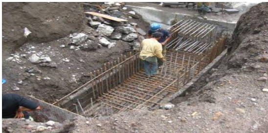
Gambar 8.8 Fabrikasi tulangan pile cap
