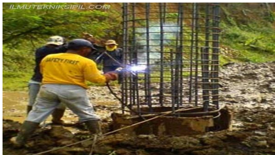
Gambar 8.7 Fabrikasi tulangan bored pile
