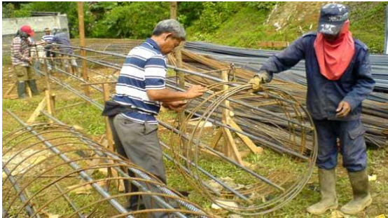
Gambar 8.6 Fabrikasi tulangan bored pile
