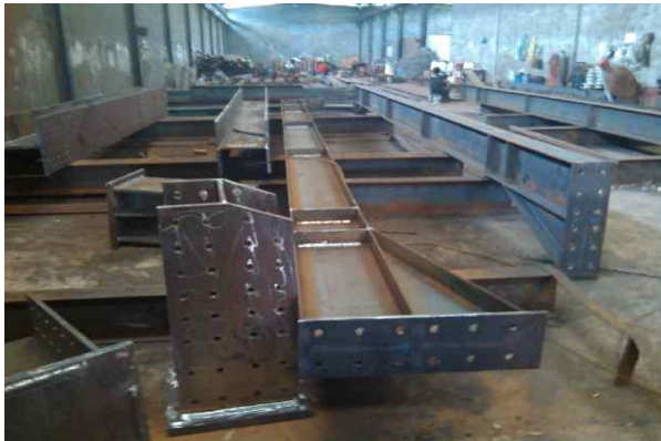
Gambar 8.9 Fabrikasi profil jembatan
