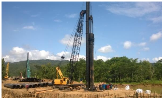
Gambar 8.5 Proses pemancangan
