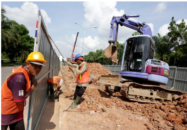
Gambar 8.3 Pembuatan pagar proyek
