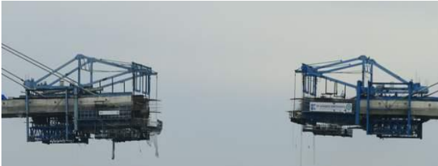
Gambar 8.11 Pemasangan Traveler
