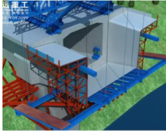
Gambar 7.22 Pemasangan Formwork untuk Segmen 1
