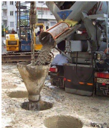
Gambar 7. 4 Pengecoran dengan Ready Mix
