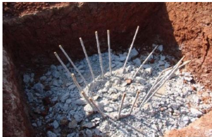
Gambar 7. 6 Pemotongan Kepala Borepile
