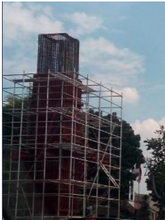
Gambar 7. 7 Pemasangan Bekisting
